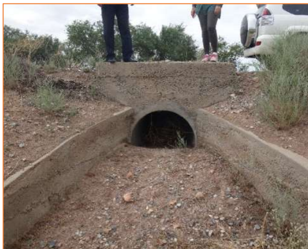
Рисунок 5 – Типовая водопропускная труба
